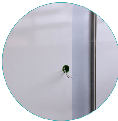
Odkrytý inštalačný stĺpik a elektroinštalácia
