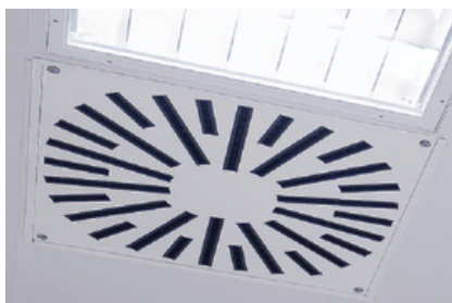
2) Vírivý anemostat s nastaviteľnými lamelami
