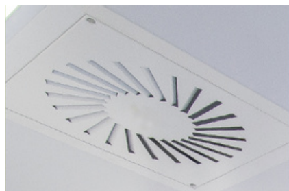
1) Vírivý anemostat s pevnými lamelami
