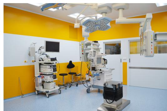
Несущая система Surgical обеспечивает равномерное распределение нагрузки от отдельных компонентов в несущие строительные конструкции. Вся система разработана так, чтобы из неё можно было создать все строительные детали, необходимых для создания операционных залов и прилегающих помещений. Система изготовлена из оцинкованной листовой стали. Компоненты крепятся друг другу взаимным прикручиванием, после чего вся система подключается к заземлению всего здания.
