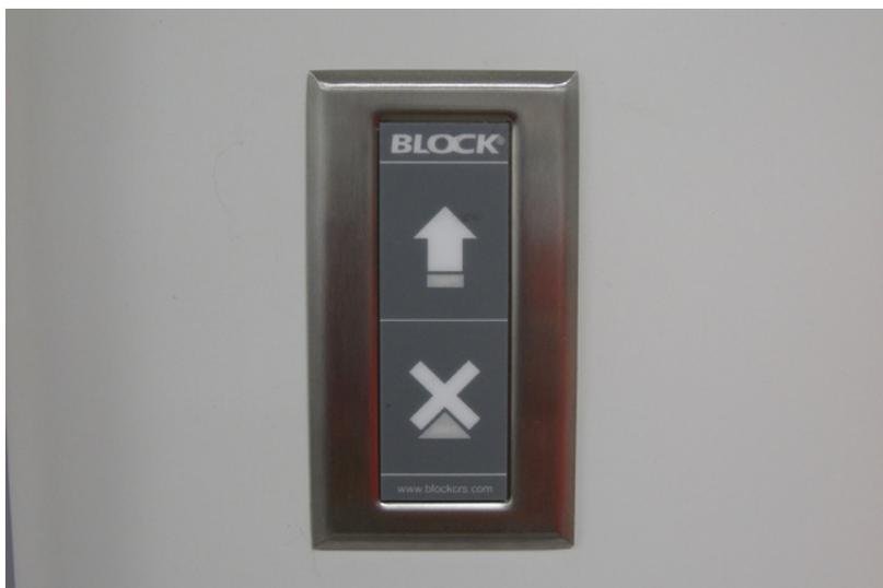
Система электронной сигнализации дверей (в дальнейшем ЭСД) позволяет персоналу чистых помещений соблюдать установленный рабочий режим перемещения людей и материала. Она состоит из двух или более сигнализационных коробок, расположенных вблизи дверей чистого помещения или над подвесным потолком. Для блокировки дверей можно использовать электронную сигнализацию в комплекте с электромагнитным замком.
