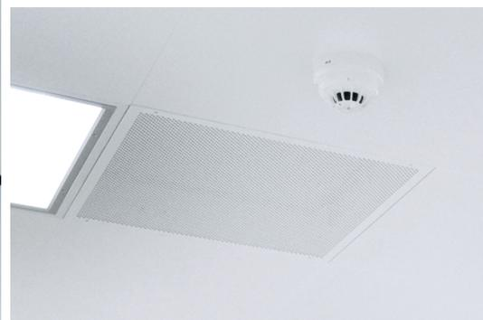
Воздухотехнические насадки являются концевыми элементами системы распределения воздуха.
