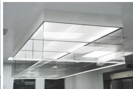
Ламинарное поле предназначено для направления подаваемого воздуха, выходящего из фильтровальных насадок PUROFIL.
