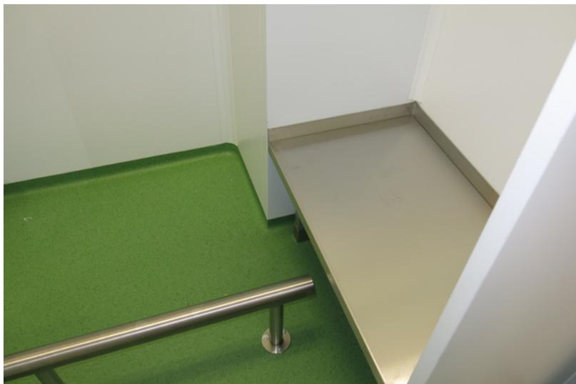
Ограждения из нержавеющей стали и защита углов служит для предохранения перегородок от повреждения во время перемещения тележек, автоклавов и т.п.
