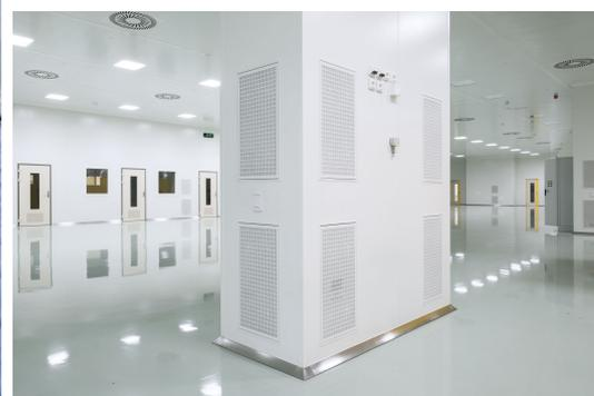
Нержавеющий фабион служит для отделки углов внутри чистых помещений (соединения: стена – стена; стена – подвесной потолок). Продукт был разработан специально для создан для легкой очистки углов эпоксидных полов и перегородочной системы для электротехнической промышленности. Фабион и его принадлежности изготовлены из нержавеющей стали AISI 304.
