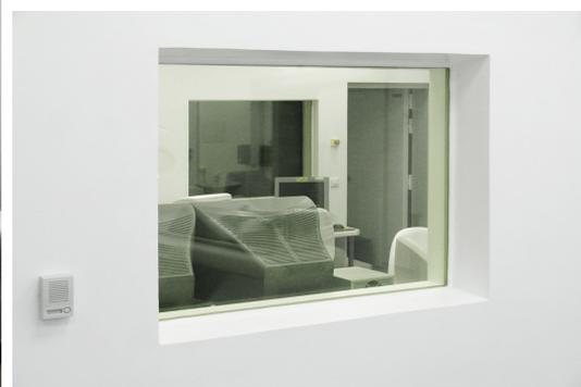
РТГ остекление перегородочных панелей является ещё одним элементом, который вместе с перегородками и дверями, служит для создания чистых помещений с защитой от рентгеновского излучения. Его конструкция особенно подходит для больниц, фармацевтических объектов, для электротехнической, машиностроительной, пищевой и химической промышленности...
