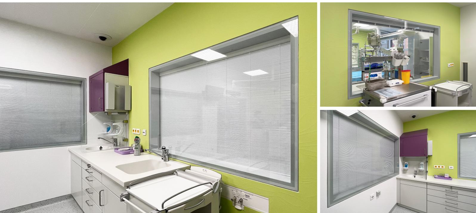
Оконная панель с полным остеклением представляет собой систему перегородочных панелей - один из основных элементов для создания чистых помещений и рабочих мест с максимальной безопасностью, стерильностью, гигиеной, простой очисткой и санитарной обработкой.
