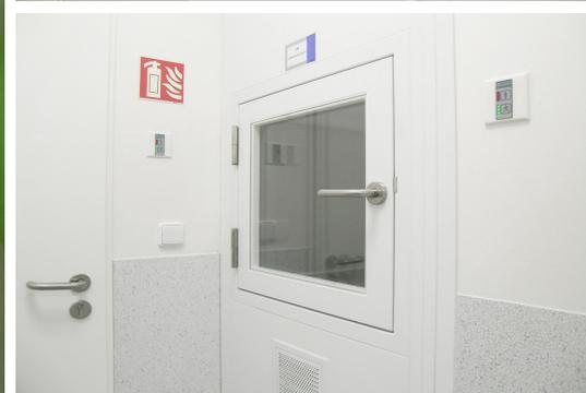
Metall-Drehtüren stellen zusammen mit der Zarge eines der Grundelemente für den Bau von Reinräumen und Arbeitsplätzen mit maximaler Sicherheit, Sterilität, Hygiene, einfacher Wartung und Reinigung dar.
