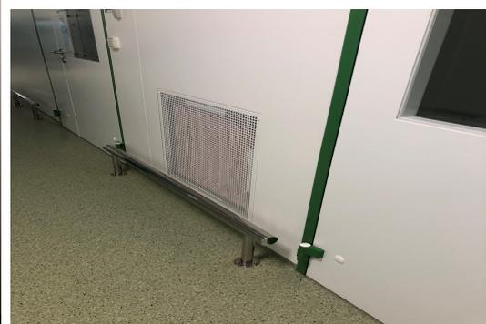
Lüftungsgitter mit Taschenfiltern dienen der Abluftführung aus Räumen oder lokalen Bereichen mit Staubentwicklung. Sie verhindern die Übertragung von Schadstoffen und Staubpartikeln in das Absaugsystem. Bei der Absaugung von Luft aus reinen Trennwänden in Lüftungskanäle genügt es, die Öffnung in der Trennwand mit einem Rahmen mit Abdeckgitter und einem Taschenfilter auszustatten.
