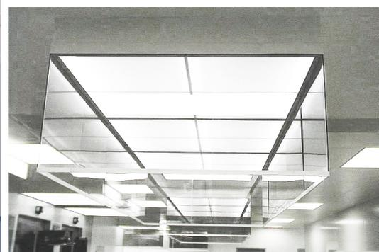
Laminare Felder dienen zur Lenkung der zugeführten Luft von PUROFIL-Filteraufsätzen, die an die zentrale Lüftungstechnik angeschlossen sind. Sie werden in leichte Kassetten-Unterdecken oder in Unterdecken mit sichtbarem Raster eingebaut.
