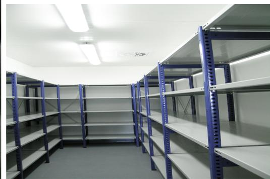
Deckenpaneele mit erhöhter Wärmebeständigkeit sind für Kühlräume und Thermokammern bestimmt. In diesen Bereichen werden Temperatur- und Druckverhältnisse gemäß den Kundenanforderungen sichergestellt. Das gesamte System zur Verbindung der Paneele untereinander und mit anderen Komponenten (d.h. Türrahmen, Deckenpaneele, Bodenverankerung) ist so konzipiert, dass alle Wärmebrücken unterbrochen und der Wärmeübergang minimiert werden.
