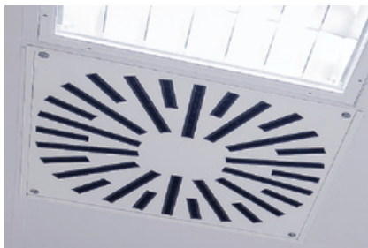
2) Vířivý anemostat s nastavitelnými lamelami
