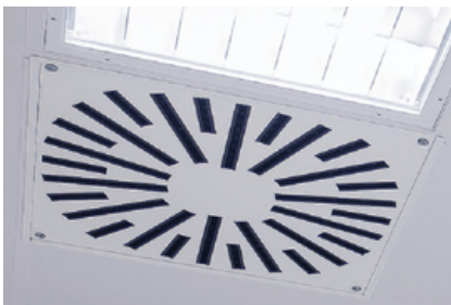
2) Vířivý anemostat s nastavitelnými lamelami
