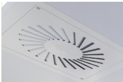
1) Vířivý anemostat s pevnými lamelami
