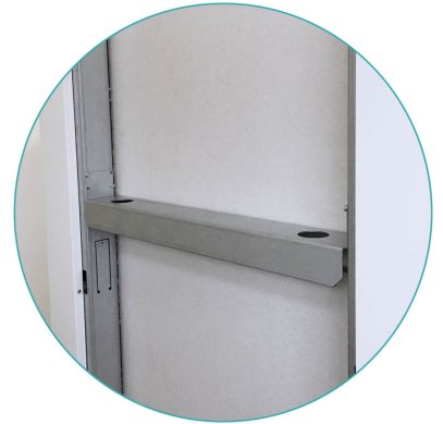
Detail nosného rastru v místě instalačního panelu
