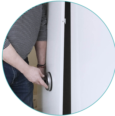
Jednoduchá demontáž instalačního panelu
