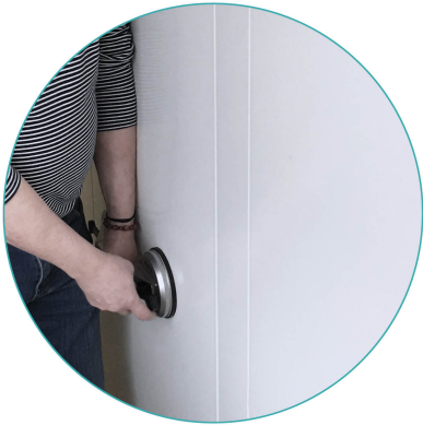
Jednoduchá demontáž instalačního panelu
