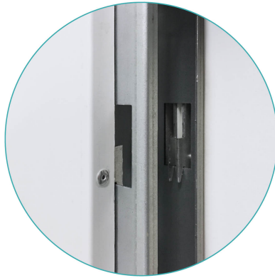
Detail usazení panelu na nosný rastr
