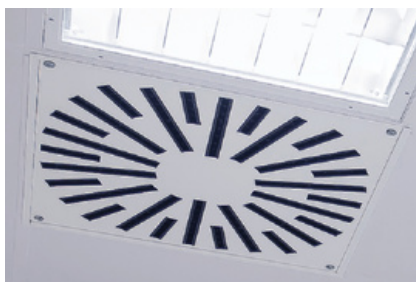
2) Vířivý anemostat s nastavitelnými lamelami
