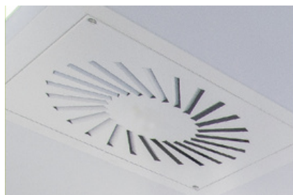
1) Vířivý anemostat s pevnými lamelami
